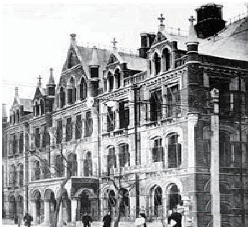
中国通商银行大楼
